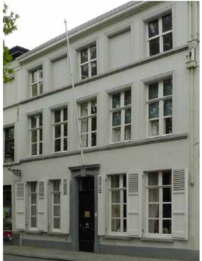
Het huis Brugge, Langerei 18, huidige toestand
